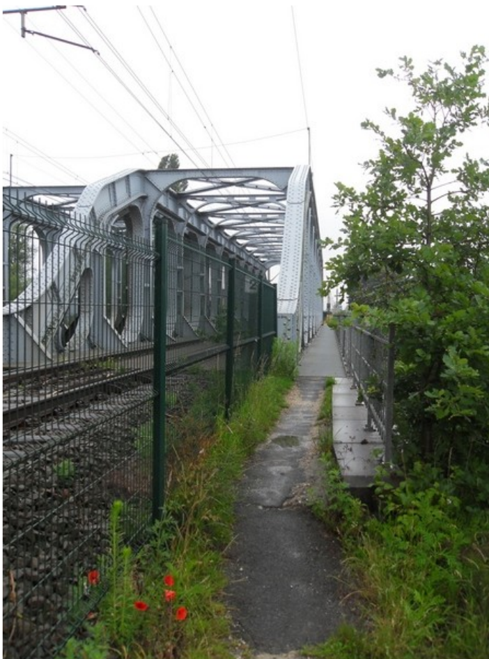
De geklonken spoorwegbrug in Grammene
