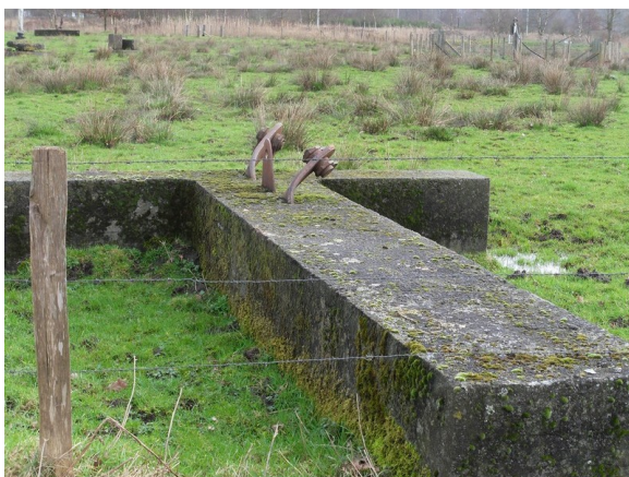
Een ankerpunt voor de tuikabels dat voorheen werd gebruikt. Is de rare vorm per ongeluk ontstaan of was dat van meet af aan zo bedoeld?
