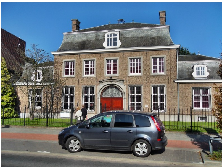
De tot restaurant verbouwde pastorie in Sint-Job-in-'t-Goor
