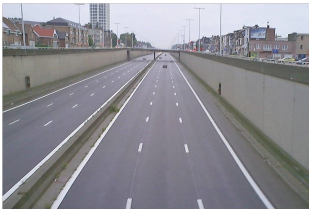
De bulderbaan in de sleuf dwars door Boom
