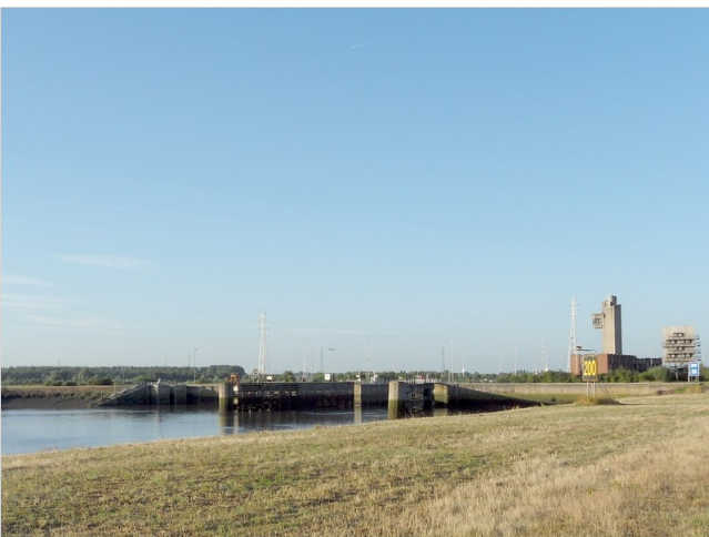
De sluizen in Wintam
