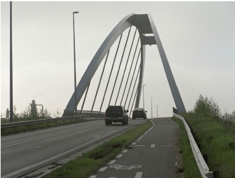
De boogvormige bovenstructuur van een brug over de Leie
