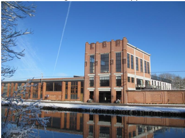
Het gebouw langs de Vaart met CBR 1930 in de gevel gemetseld.
