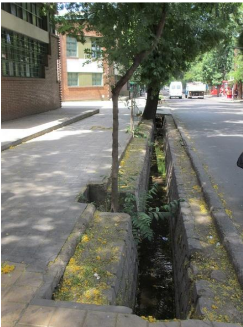
Acequias, yanqi traps. De kanalen voor de bevoeding van de talrijke bomen in de stad
