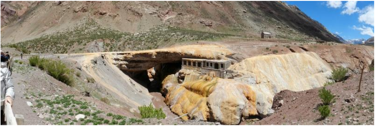
De Puente del Inca
