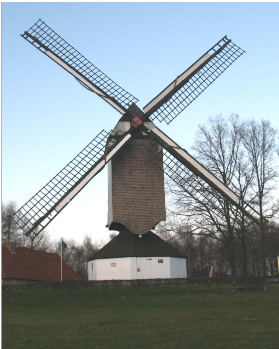
De Kaasstrooimolen. Een staakmolen met gesloten voet. Gebruikt als graanmolen. Auteur: Noorse at nl.wikipedia
