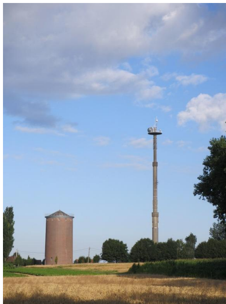
Op de heuvelrug naar Ossel staan deze watertoren en de antennemast. Van waar de foto gemaakt werd, staat er nog een tweede mast.
