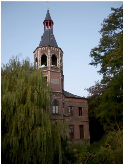
Kasteel „De Bocht“ met de gerestaureerde toren.
