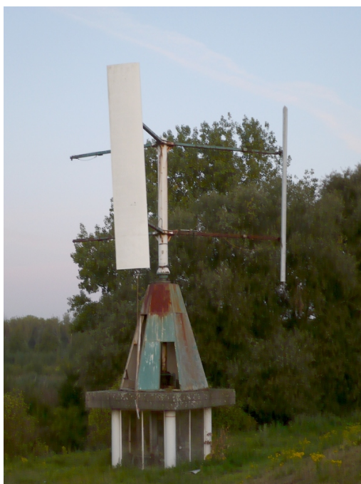
Een ongewone windmolen. Dringend aan herstel en restauratie toe.
