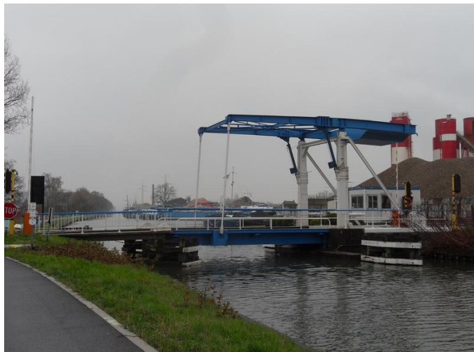
Een beweegbare brug over het kanaal Dessel-Schoten
