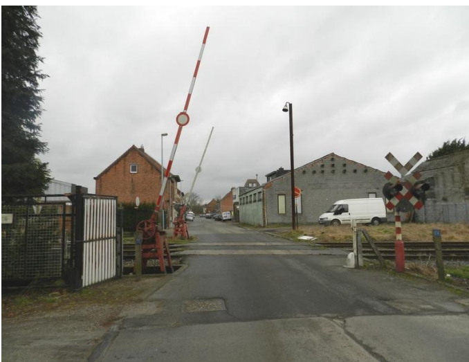
Een overweg waarvan de slagbomen nog met de hand moeten bediend worden
