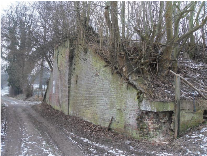
Het restant van de viaduct van de trambaan over de Kamstraat
