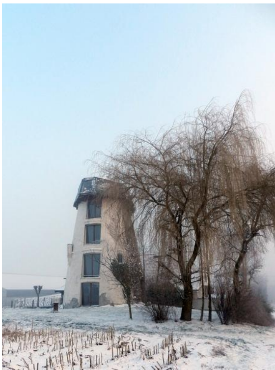
De romp van de Thienpontsmolen. Nu een woonhuis.
