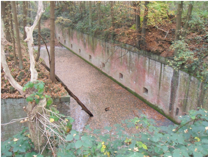
Een deeltje van Fort Steendorp. Het baksteenmetselwerk en de eens droge grachten.
