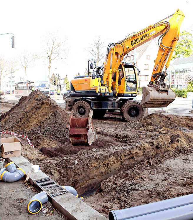
••• Herentalsebaan. De werkzaamheden aan het fietspad en de trambedding op de Herentalsebaan lopen enige vertraging op.
