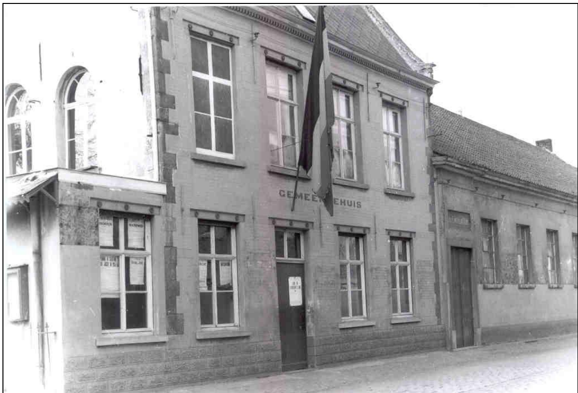
Illustratie 8. Het oude gemeentehuis van Kalken met aanpalende kantschool (rechts) werd in de periode 1962-1963 afgebroken.
