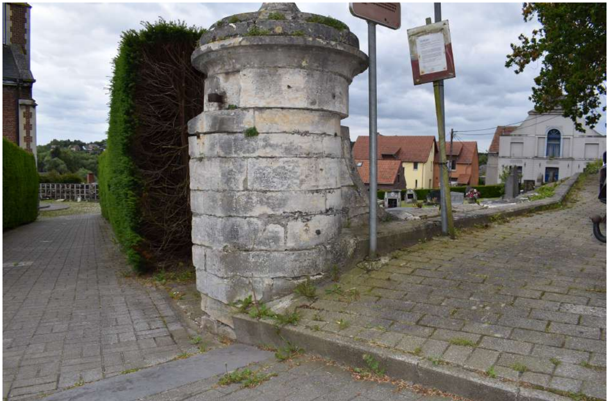
Parking: deze is verhoogd tov de oorspronkelijke kerkmuur waardoor ook de eik meer is ingegraven.
