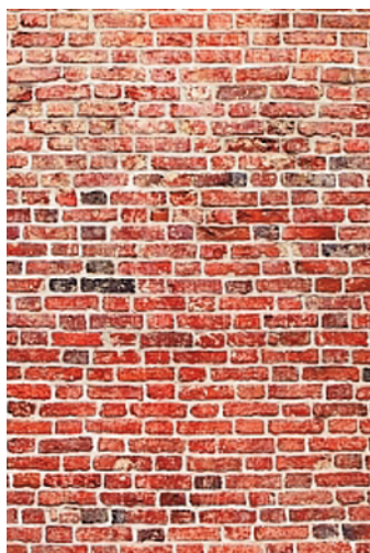
Zelfs een blinde muur kan na een opknapbeurt fraai ogen.
