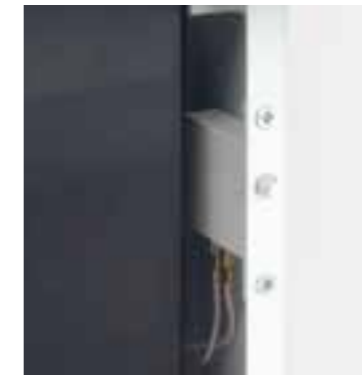
Tamper microswitch on box door
