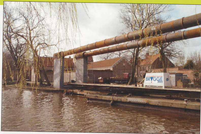
De brug die Jürg Conzett ontwierp voor Brugge 2002. Twee grote stalen buizen torsen een eiken brugdek.
