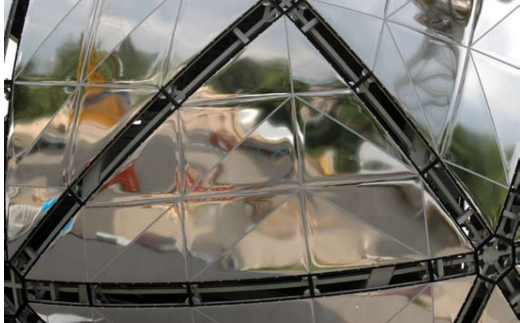
In de 48 driehoekige panelen zijn schijnbare voegen aangebracht. Daardoor vervormt de reflectie zoals in een spiegelpaleis.
