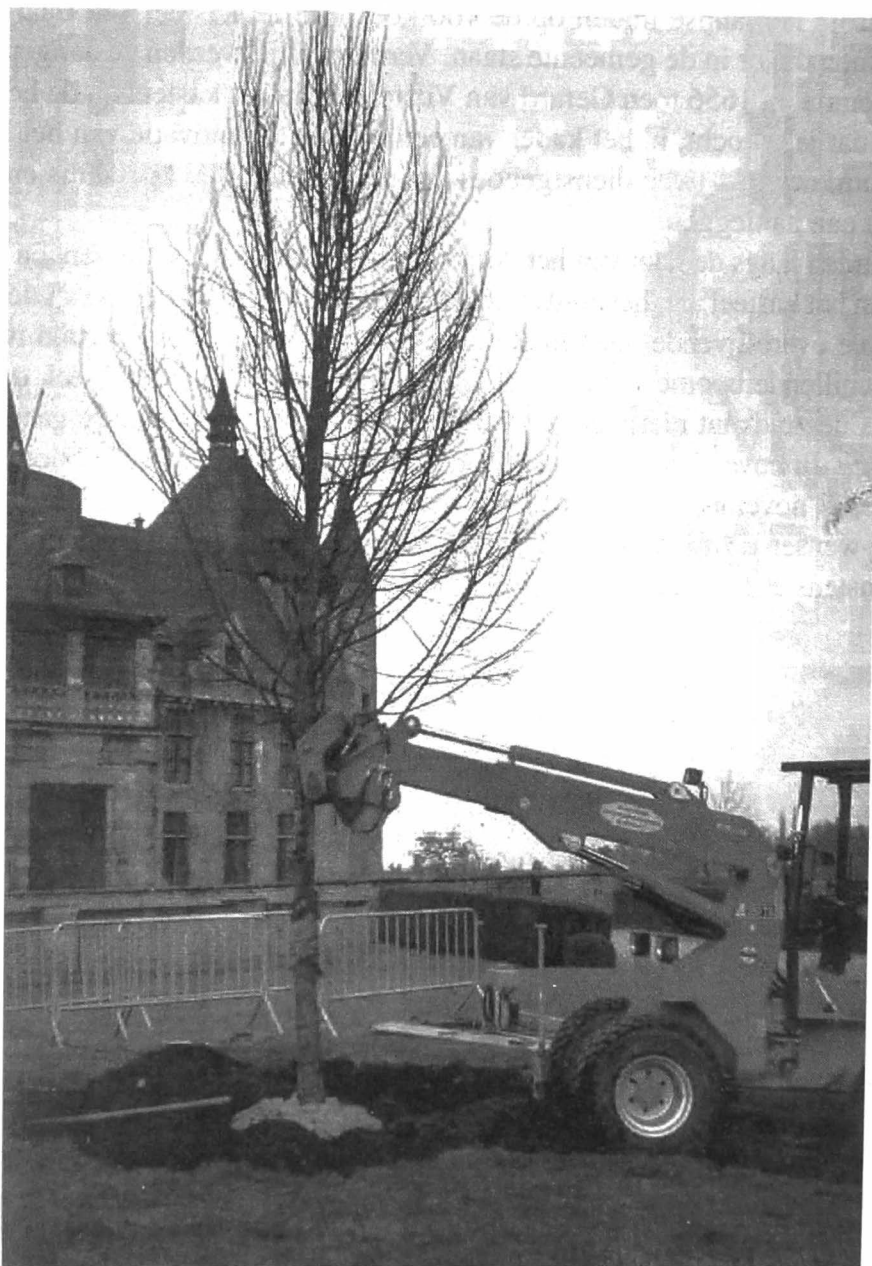
Fig. 2: De nieuwe Hollandse linde wordt machinaal in het plantgat neergelaten.
