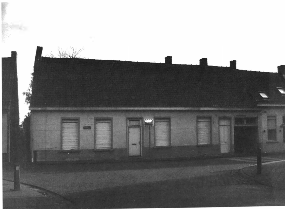
Afbeelding 5. Voorgevel van de woning in de Koffiestraat die ooit als herberg, kruidenierszaak en ambachtswoning dienst deed.
