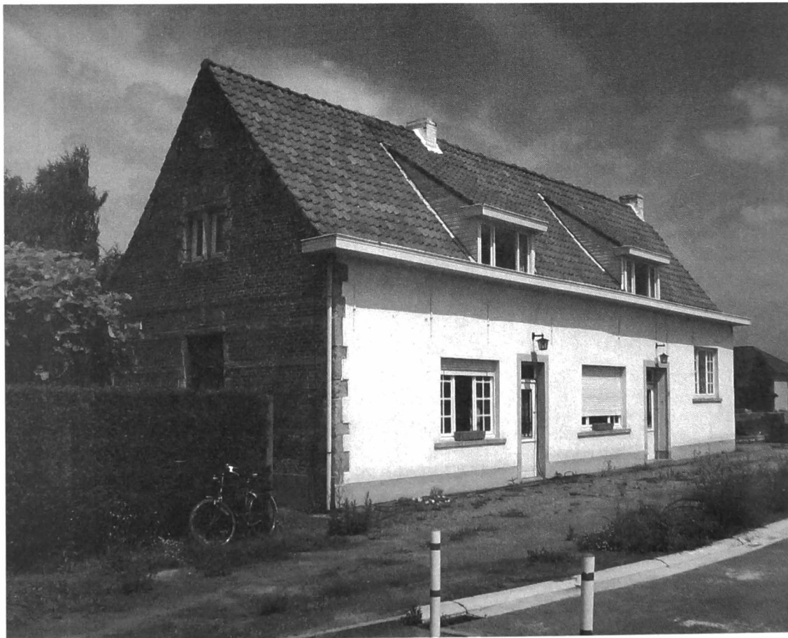
Afbeelding 7. Zicht op de woning in Kalkendorp.
