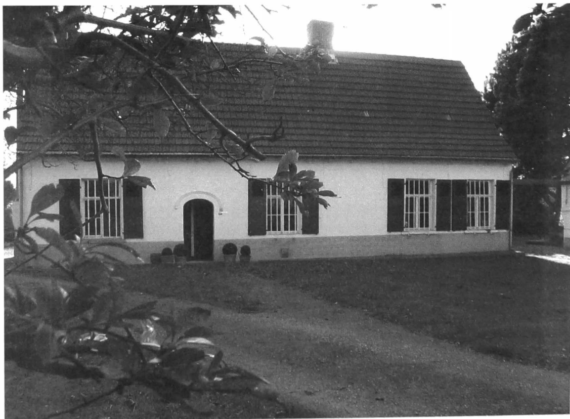
Afbeelding 12. Voorgevel van de woning Termstraat 53.
