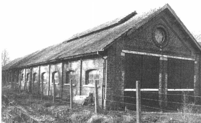
Illustratie 2. Zuidelijk deel van de busstelplaats. Let op de speciale dakconstructie om de stoom van de stoomtrams te laten ontsnappen. Foto Pascal Lachaert, 2003.
