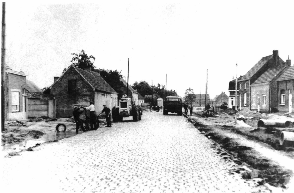
Afb. 3: Werkzaamheden aan de provinciale weg N 445, ter hoogte van de Heirweg, juli 1963 (fotografie Cyriel Seghers).
