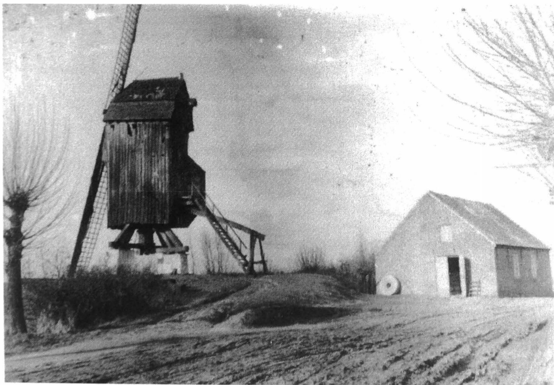
Illustratie 3. De houten korenwindmolen kort vóór de afbraak, met half wiekenstel. Rechts het gebouwtje waarin de maalderij is ondergebracht. Verzameling Stadsarchief Lokeren.
