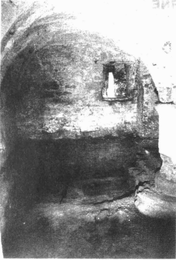
Fig. 1. Zicht in de zuidelijke kelderruimte. In beide kelderruimtes werden sporen van de houten grachtbeschoeiing teruggevonden.
